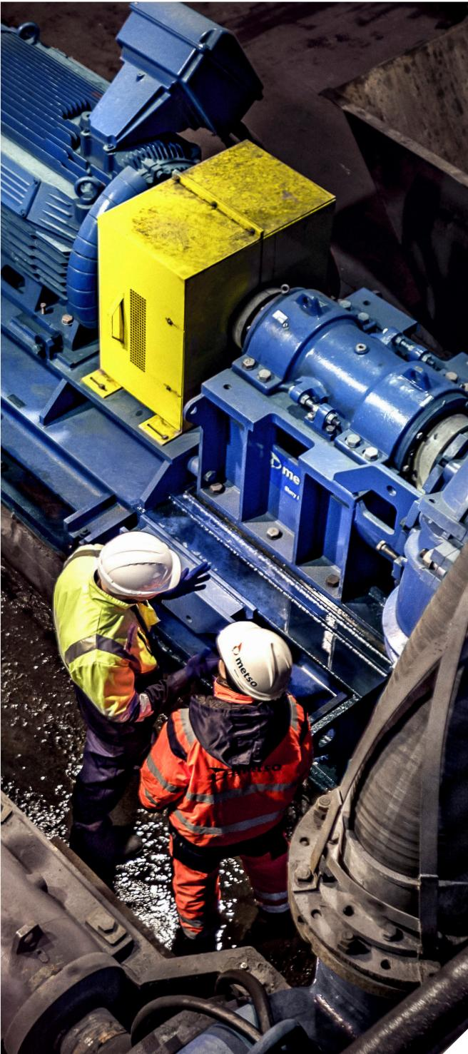
Nossas duas linhas de bombas MD - MDM (metal) e MDR (borracha) - foram projetadas desde o início levando em conta a sua aplicação para a descarga de moinhos. Ambas as linhas proporcionam um desempenho contínuo e duradouro, reduzindo, assim, a necessidade das paradas de planta para manutenções frequentes.
